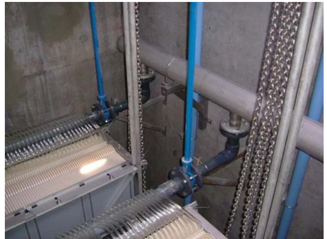
Vue de dessus des modules membranaires
